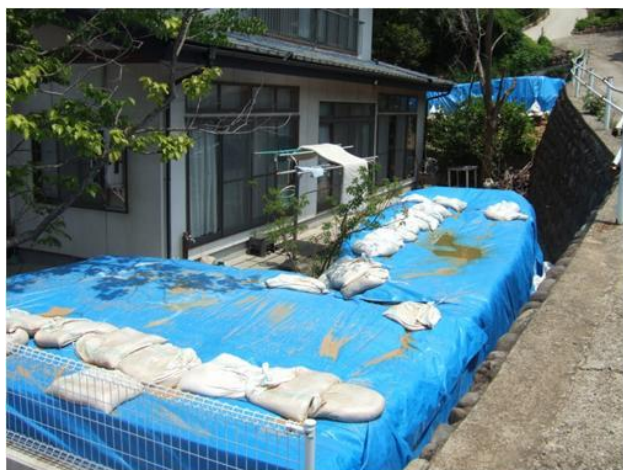
図 8 渡利地区での除染土の処理
