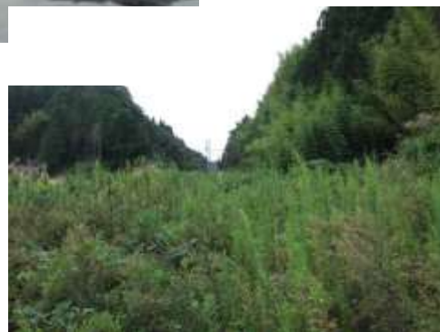
不通となった常磐線の線路 (ただの草むらとしか見えない)
