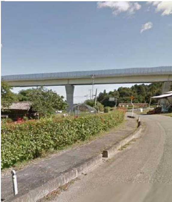
① 高速道路の高架橋（片倉地区）
