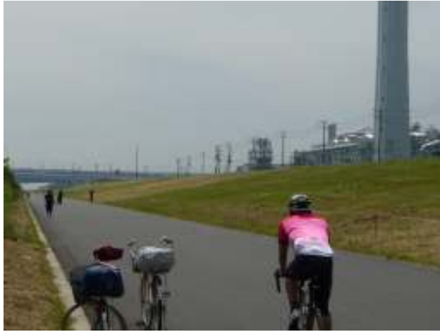
東部スラッジプラント(右奥)と荒川土手
